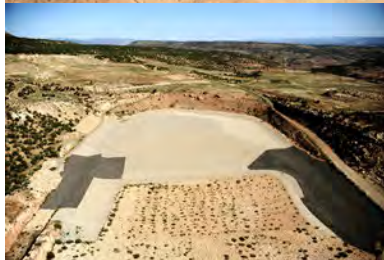
Uravan Disposal Cell, CO.
